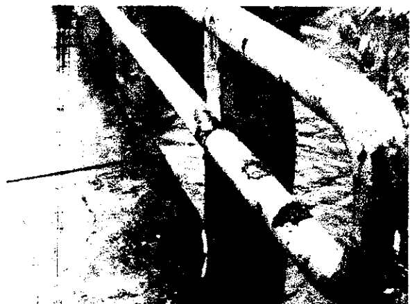
Foto N° 18 barandas en mal estado
