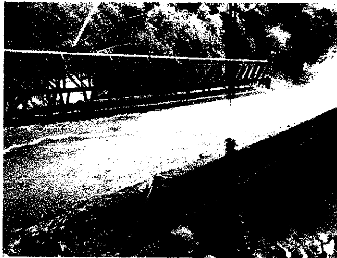
Foto N° 1. Vista general del puente.
