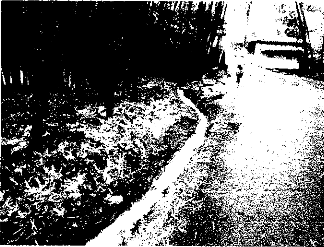
Foto N° 6 cuneta natural sin revestir
