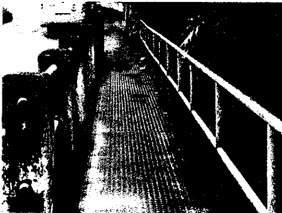
Foto N° 16 y 16 A Pasarela metálica, requiere mantenimiento de soldaduras y protección pinturas en estructura y zona de tránsito
