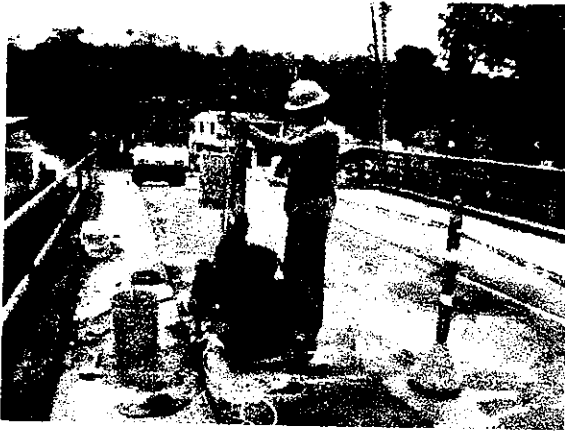
Foto A Mapeo Tablero, para determinar localización refuerzo y zona para perforar
