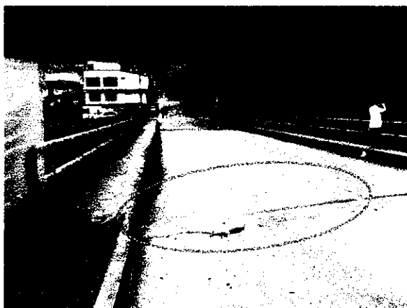
Foto N° 11 y 12 Daños en superficie de aproximación y juntas. Andenes
