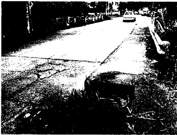
Foto N° 6 Desagües próximos al puente, requieren mantenimiento
