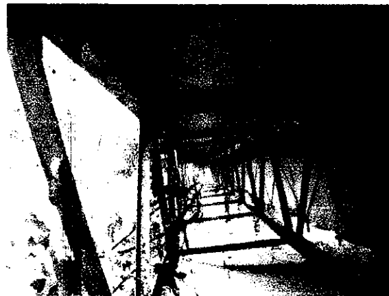
Foto N° 16 y 16 A Pasarela metálica, requiere mantenimiento de soldaduras y protección pinturas en estructura y zona de tránsito
