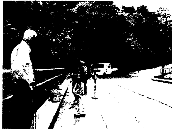
Foto D Extracción de núcleos
