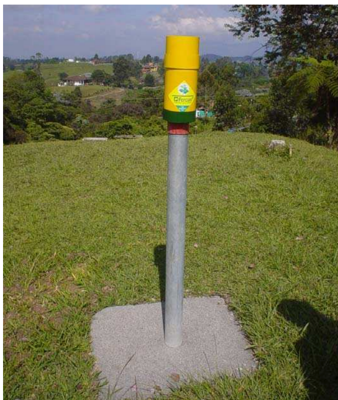
Foto 16. Pluviómetro ubicado en la Planta de Tratamiento
