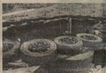
Foto 7. Construcción pecera con llantas usadas. 30/04/2018.
