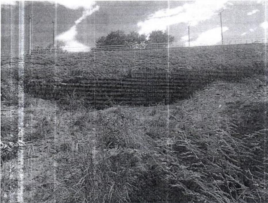
La imagen muestra el aspecto que tiene a la fecha la empradización del muro en tierra reforzada, denominado hacia el interior de la obra como muro 3, se aceptó la recomendación dada por el proveedor del prado de ustedes relacionada con sembrar en la cara del talud pasto tipo estrella, a la fecha no ha rebrotado, se le debe hacer mantenimiento a la mayor brevedad, no solo a este sector sino a los demás muros en tierra reforzada.
