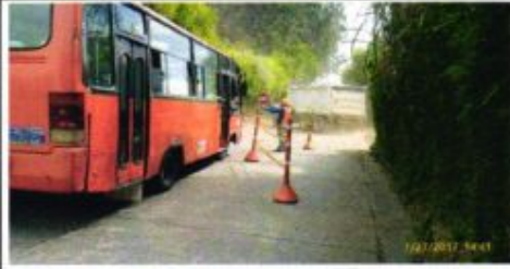
FOTO No.1, Uso de personal "PARE-SIGA", para el retiro de volquetas de la obra
