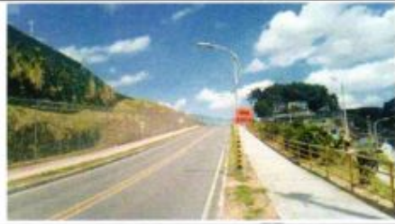
FOTO No.3, Estado inicial de la vía K0+050
