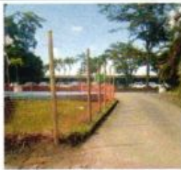
FOTO No.7, CERRAMIENTO MALLA NARANJA PERFORADA + SEÑALIZADOR TUBULAR
