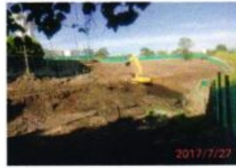
FOTO No.8, Descapote y cargue de material para retiro.
