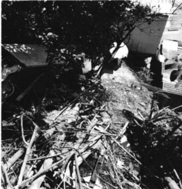
Con respecto a la casa 12, se observa un hueco debajo de ella donde se meten los de la vivienda 14 a extender ropa..., con viga a la vista y sin columna de soporte, y se alcanza a ver que el techo de la casa 12 no tiene canal lo que genera que el deslizamiento y posiblemente el deslizamiento aumente
