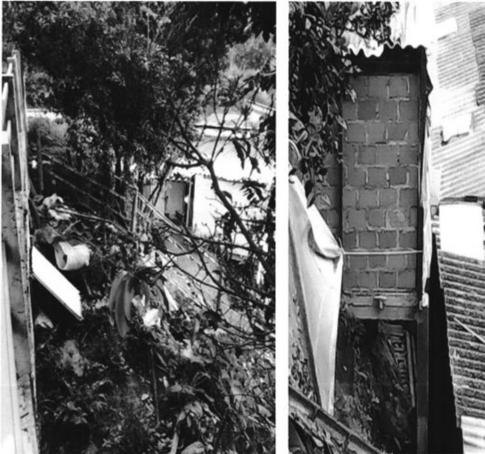
Acá se aprecia que la casa 12 continúa sin canal, y después de cambiar la pared por ladrillo tampoco la colocaron.
