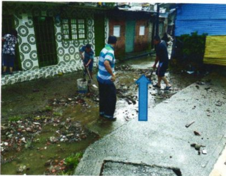
En estas fotos evidenciamos el estado de la calle y los sumisos a la hora de presentarse los aguaceros con estas evidencias sustentamos la problemática de gran magnitud que está afectando al barrio la laguna.
