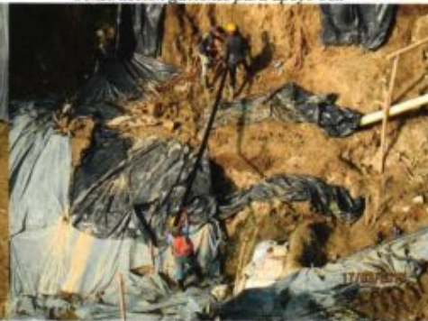
Instalación tubería para drenes subhorizontales
