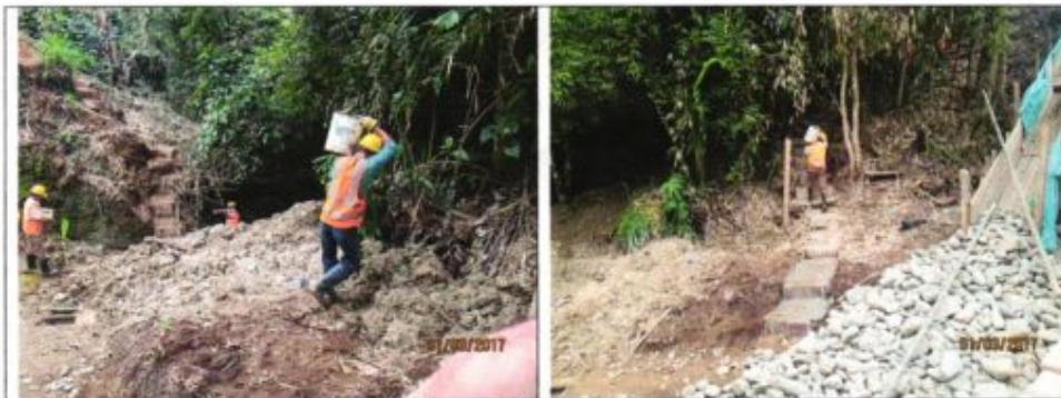
Retiro manual de excavación hasta la parte alta del talúd
