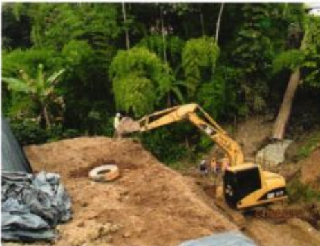
Adecuación mecánica de terrazas para ingreso al sitio
