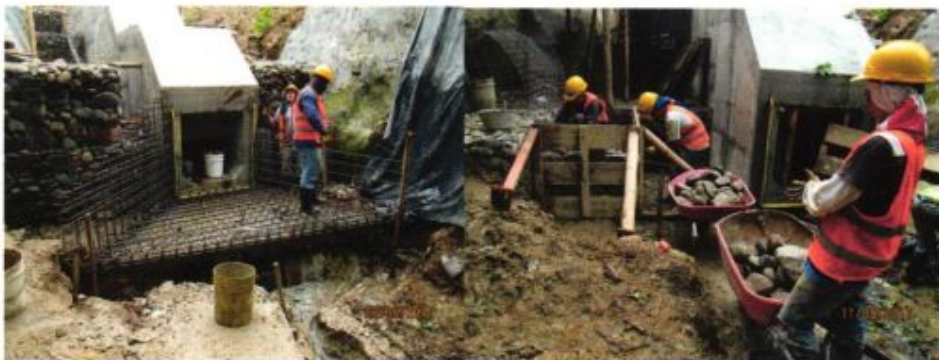
Construcción salida box culvert
