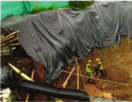
Perforaciones para drenes subhorizontales talud
