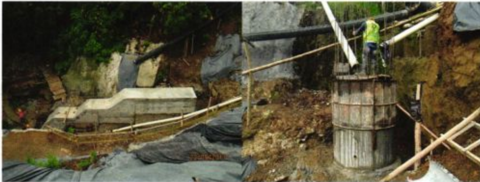
Vista lateral del boxculvert en concreto
