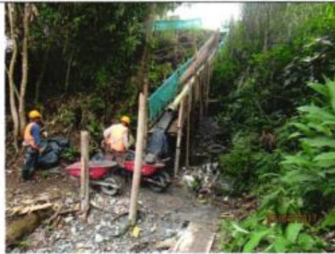
Descarga y sobreacarre horizontal piedra para gavión
