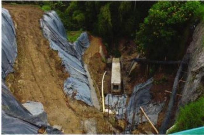
Estado de avance a la fecha obras de estabilización
