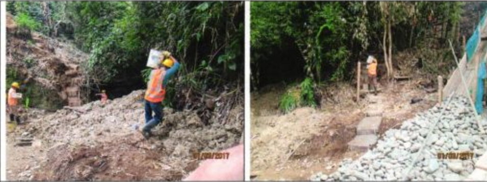
Retiro manual de excavación hasta la parte alta del talud
