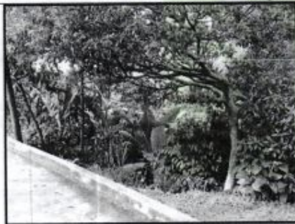
Foto 1. Aspecto de la cobertura vegetal en la corona de la ladera
