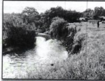
Foto 2. Deslizamiento margen derecha aguas arriba
