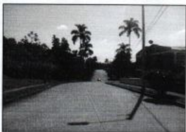
FOTOGRAFIA N° 02 Sentido Norte - Sur Calle 98
