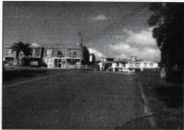
FOTOGRAFIA N° 01 Sentido Sur - Norte Calle 98
