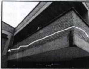
Foto 11. Muro en voladizo
