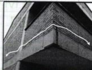
Foto 12. Muro en voladizo
