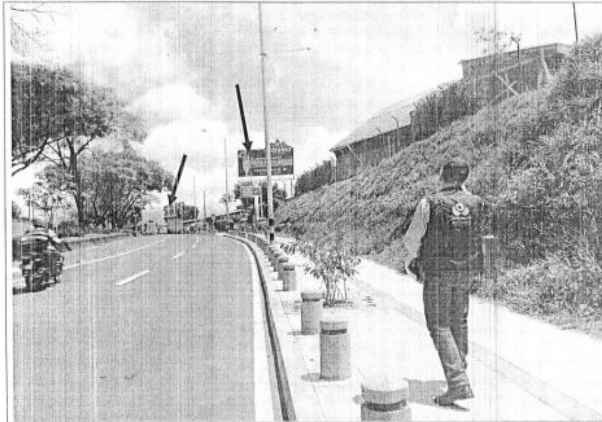
Fotografía Nro. 01: Parte externa del Colegio "AQUILINO BEDOYA", ubicado en la Avenida 30 de Agosto Nro. 62-59 frente al Aeropuerto Internacional Matecaña de la ciudad de Pereira. En ésta toma se detalla la valla publicitaria existente en predios de dicho claustro estudiantil, al igual que la estructura de otra valla pendiente por utilizar y que se observará más adelante.
