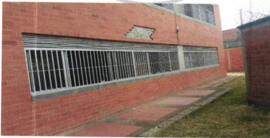
BLOQUE ACADÉMICO PARED POSTERIOR SEGUNDO PISO Anexo 2.
