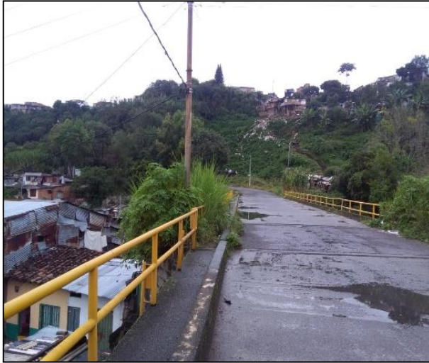
Fotografía 5. Puente Mosquera con vista a la ladera del río Otún que corresponde al municipio de Dosquebradas.
