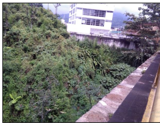
Fotografía 17: Zona de difícil acceso tramo quebrada La Dulcera.
