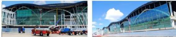
Construcción Nueva Terminal
