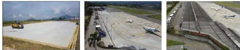
Ampliación y Adecuación Plataforma
