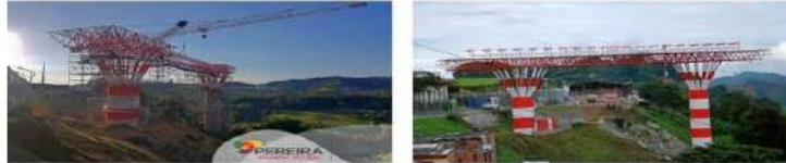
Finalización Obra ILS
