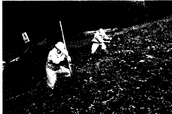
Adecuación del terreno
