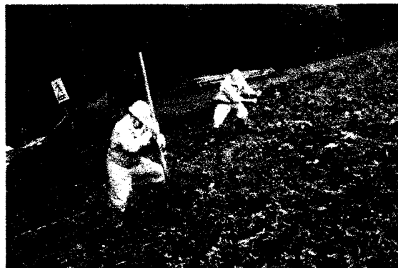
Adecuación del terreno
