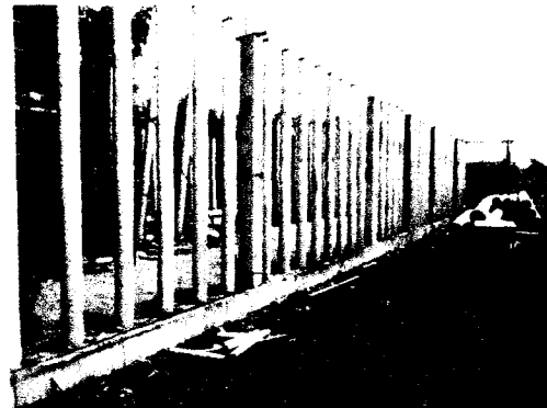
Aspecto de la columnas en acero inoxidable D=8" casa de noche elefante.
