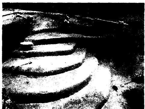
Aspecto de las excavaciones y perfilacion manual para la construcción del foso humedo en el exhibidor de elefante macho
