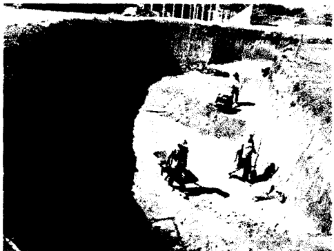
Aspecto de las excavaciones y perfilacion manual para la construcción del foso humedo en el exhibidor de elefante macho
