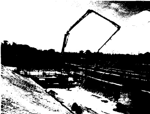
Fundición muros casa de noche elefante
