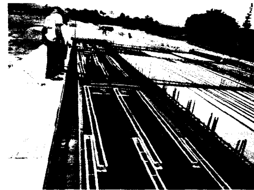
Encofrado columnas casa de noche elefante. Refuerzo placa de entrepiso rinoceronte
