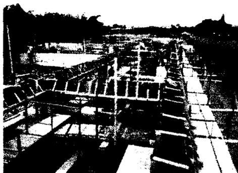
Aspecto de la estructura en casa de noche de elefantes, se observan las vigas de remate de cubieta ya listas para el vaciado
