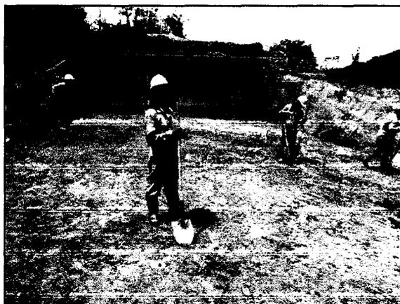
El terreno encontrado visualmente se define con suelo natural limo arenoso café claro sobre el cual se puede cimentar la estructura de la subestación y el transformador, la zona de llenos debe ser adecuadamente compactada para el momento de la visita no se observó equipo apropiado para realizar la labor.
