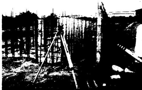
Estructura casa de noche rinoceronte, se observan las columnas en concreto y las columnas en Acero inoxidable de 8" y las pantallas en concreto. Se anota que las columnas en acero inoxidable no se observan con brillo ya que este es el estado en que llegan a la obra con una capa de protección, si se desea se puede realizar un proceso de pulido hasta dejar con mejor brillo.
