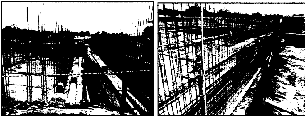
Acero de refuerzo pantallas y columnas, cimentación de la casa de noche rinoceronte.
