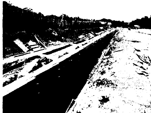
Aspecto terminado muro en concreto foso seco Elefante hembra
