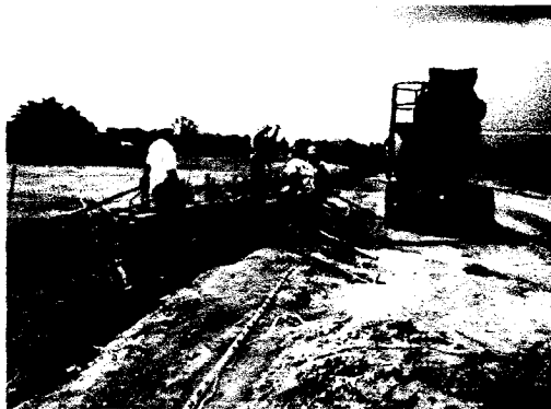
Fundición de muro foso seco
