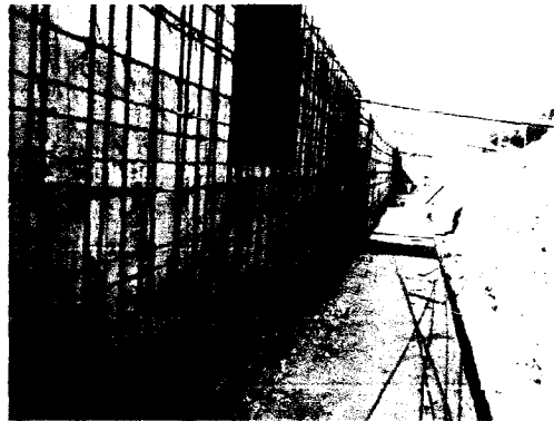
Encofrado del muro del foso seco.
