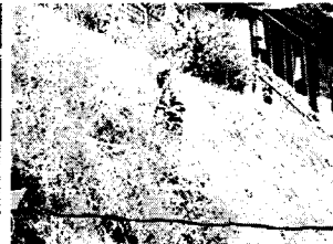
Mantenimiento de muros sembrados con pasto trenza
