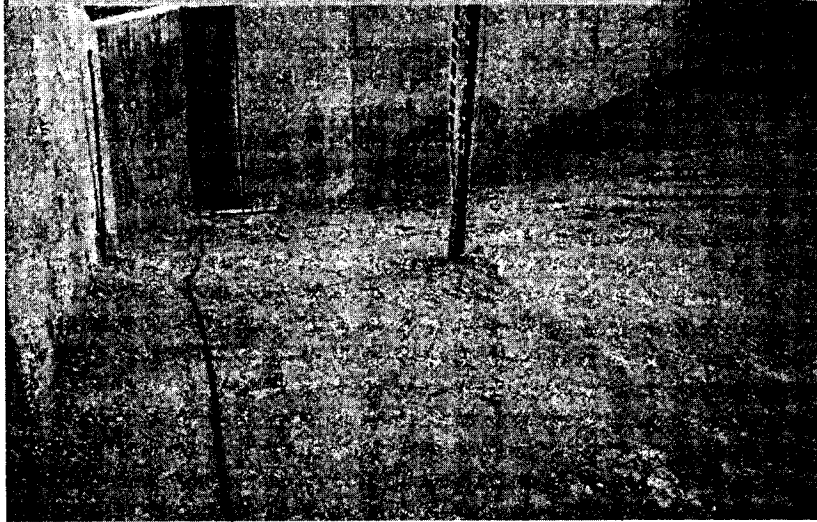
Muro de contención perimetral
