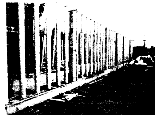
Aspecto de la columnas en acero inoxidable D=8" casa de noche elefante.
