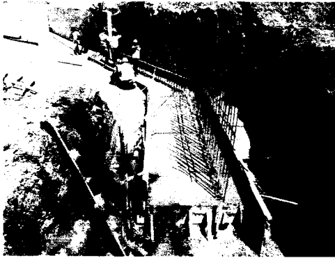
Armado de refuerzo foso seco patio elefante Macho.
