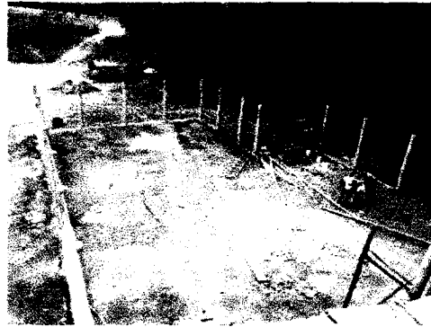
Aspecto de las columnas metálicas del patio de asoleo de elefante hembra, se observan los cables de acero instalados y sin tensionar.
