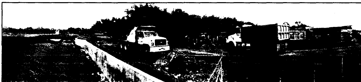
Panorámica de la obra y equipo de transporte de retiro de sobrantes
