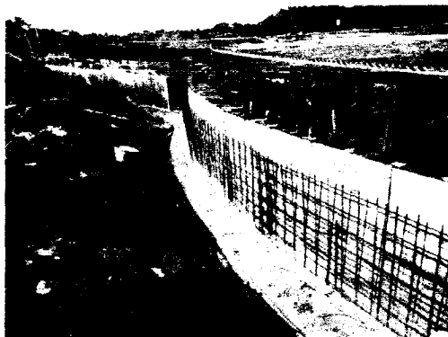
Muro en concreto sabana 1
