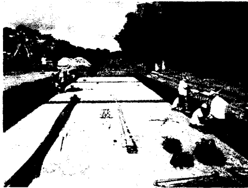
Armado de refuerzo cimentación casa de noche de elefante
