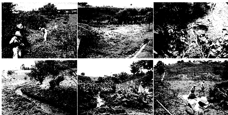
Mantenimiento de cunetas
