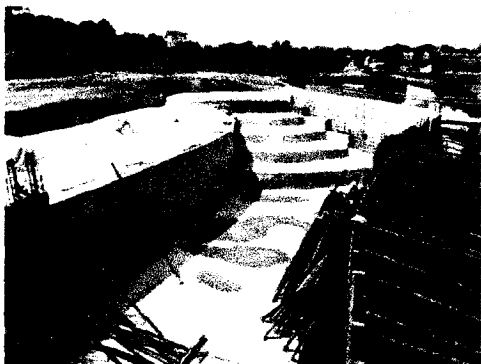
Vistas de los muros y piso del foso humedo del exhibidor de elefante hembra, se observa además el acero de refuerzo para la zona de playa y el vaciado en concreto de la misma.
