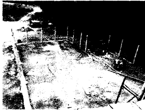
Aspecto de las columnas metálicas del patio de asoleo de elefante hembra, se observan los cables de acero instalados y sin tensionar.
