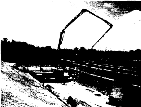
Fundición muros casa de noche elefante
