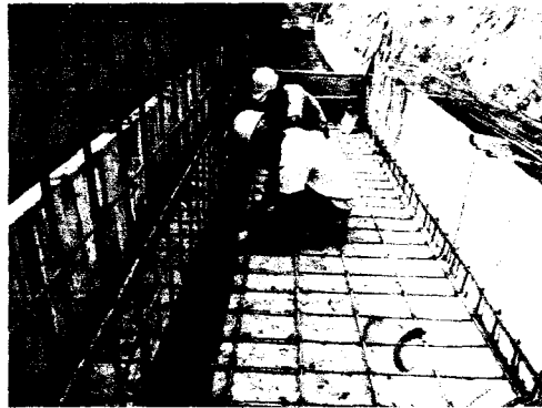
Armado del refuerzo de la zapata del foso seco
