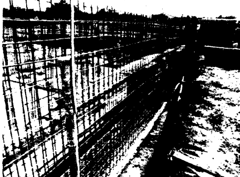
Aspecto de la cimentación de la casa de noche de rinoceronte, las vigas ya estan fundidas
