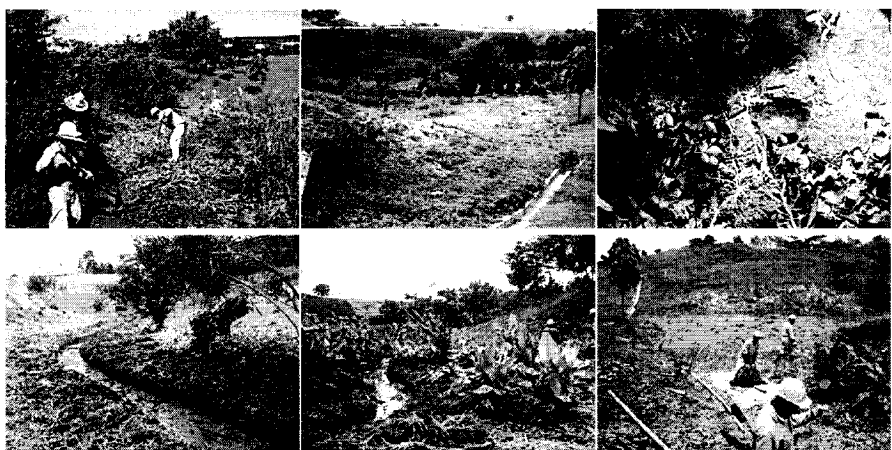
Mantenimiento de cunetas
