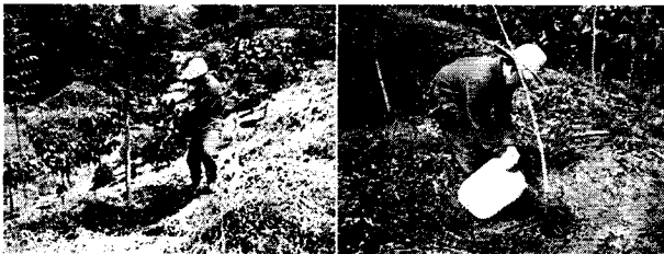
Limpieza de canales de drenaje de aguas servidas
