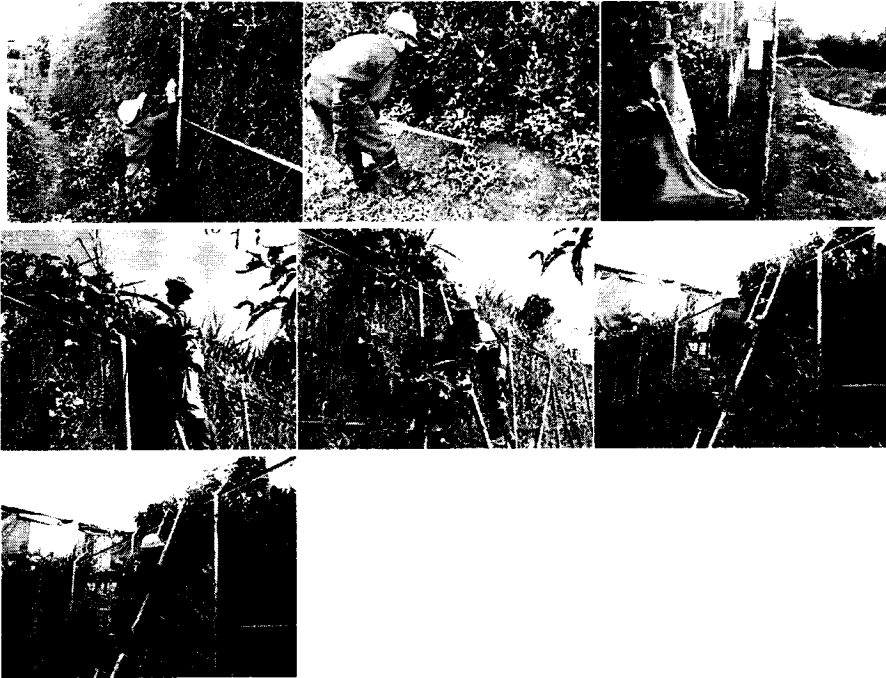
➤ Limpieza exterior de malla de cerramiento
