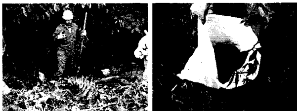
Acondicionamiento de sitio para ubicación temporal de plantas nativas recuperadas de guaduales intervenidos.
